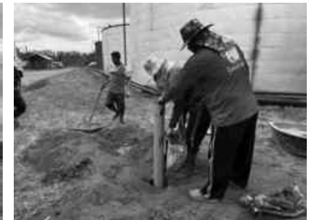
เทกรวดซึ่งทำหน้าที่เป็นวัสดุกรอง
