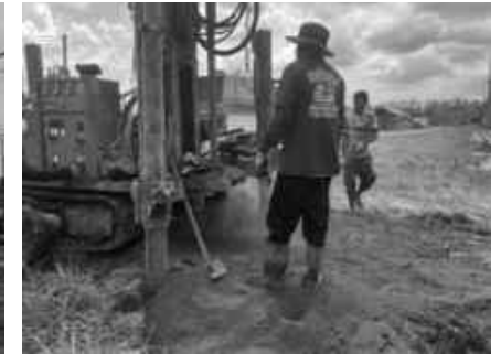
ใส่ท่อกันดินฟุ้งขณะทำการขุดเจาะ
