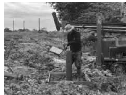
ติดตั้งท่อเหล็กครอบบ่อสังเกตการณ์น้ำใต้ดิน
