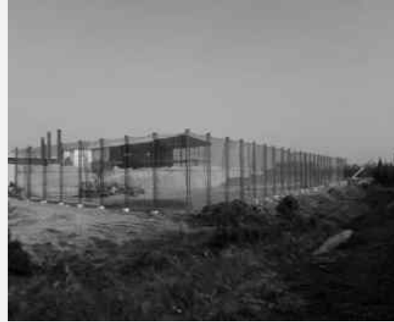
จัดทำโครงเหล็กค้ำยพลาสติกโพลีเอทิลีนรอบพื้นที่กองขานอ้อยเพื่อลดการฟุ้งกระจาย
