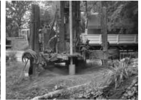
ใส่ท่อกันดินขณะทำการขุดเจาะ
