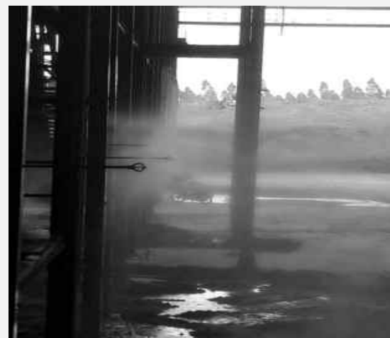
ระบบหัวพ่นน้ำ (Sprinkler) รอบกองขานอ้อยทั้งหมด
