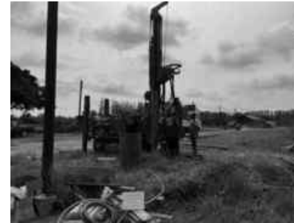
การขุดเจาะด้วยเครื่องเจาะสำรวจ
